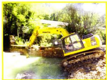
Démantèlement partiel de la digue de Cordaret
