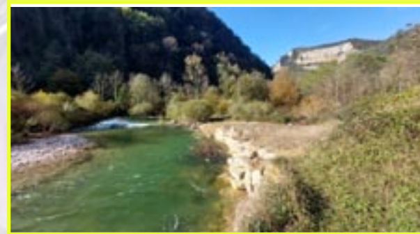
Travaux 2023 en technique minérale et végétale entre Saint-Rambert et Argis (la Grange à Guy)
